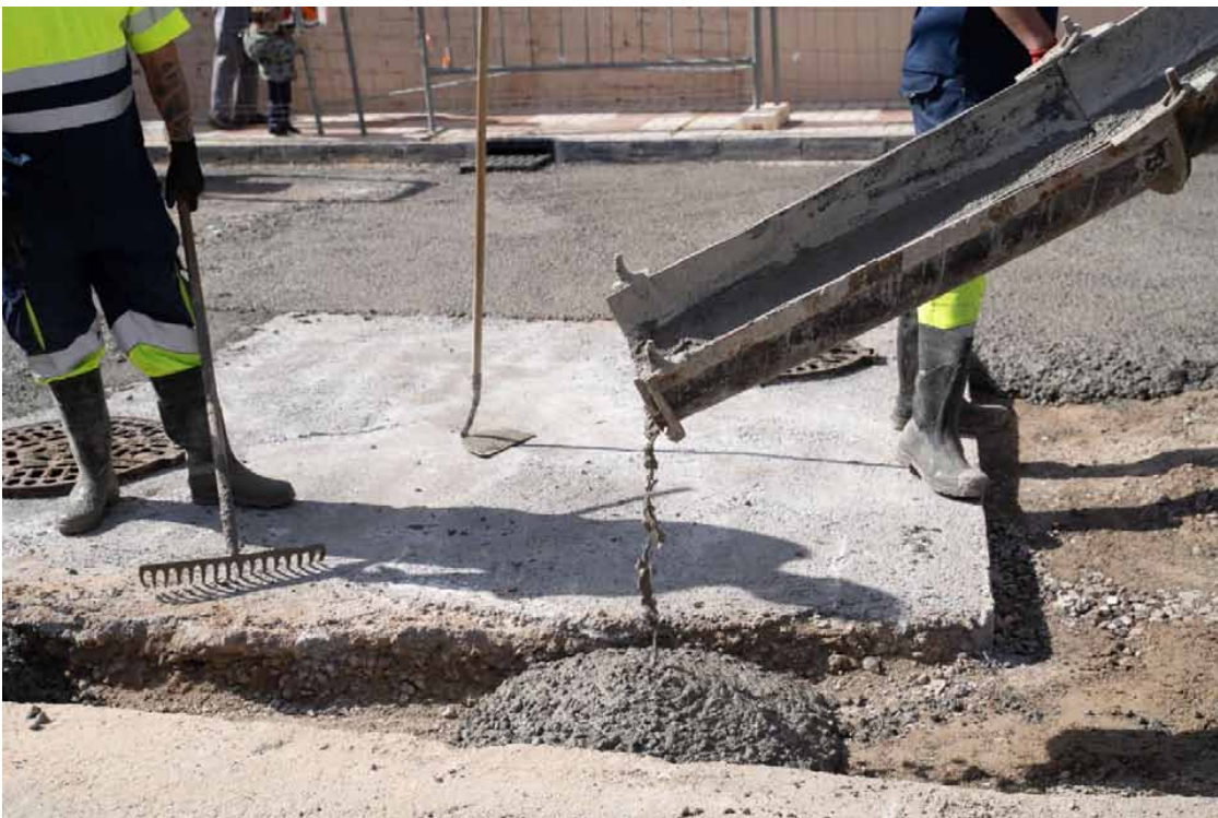
Obras. - Ayuntamiento de Benalmádena
