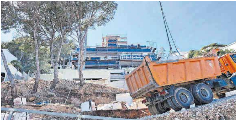
Chalé en construcción en la costa de les Rotes de Dénia.
