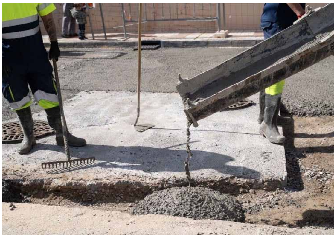
Trabajos en la calle Moscatel.
